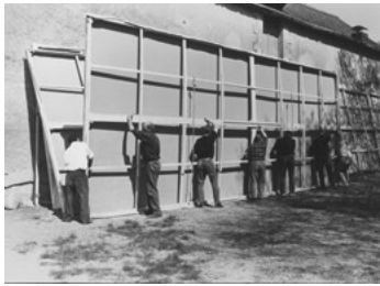
Sortie des grands toiles de Debré de l'atelier des Madères, 1991, photo : F. Poivret - CCCOD, Tours
