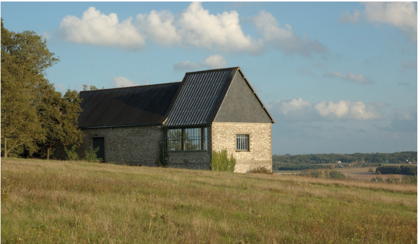
L'Atelier Calder à Saché photo : Guillaume Blanc / Atelier Calder, Saché
